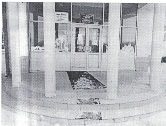
№2 вход в здание
